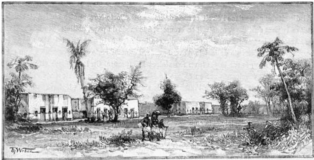
ABOMEY : PALAIS DE SIMBÓDJI, APRÈS L'INCENDIE.
